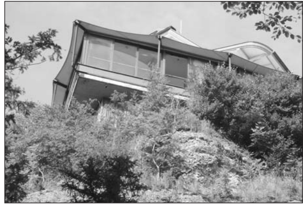
1 Heute ist die Rondoterrasse verglast und überdacht. Illegal. Um auf diesen Aussichtspunkt zu gelangen, müsste man das ganze Restaurant durchqueren.
