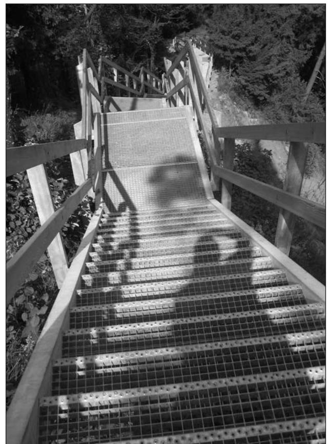
Das Rutschgebiet wird mit einer kräftigen Metalltreppe überquert. Die Konstruktion bietet Sicherheit, ist aber ein massiver Eingriff in die Landschaft.
