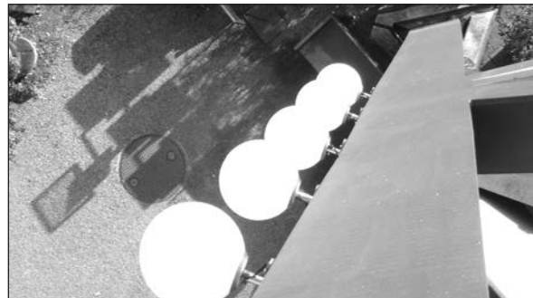
Ohne Bewilligung montiert: Turm-Beleuchtung.
