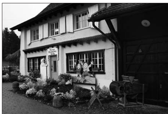
Den Eltschingers genügt das Näfenhaus mit dem Restaurant Chnuschperhüsli/Häxehüsli nicht mehr. Jetzt muss ein Hotel her – 4 Stockwerke hoch!
