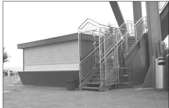
Der Klotz des Anstosses: der illegale Kiosk. Jetzt laviert der Kulm-Wirt, unterstützt von den Stalliker Behörden – gibts nicht doch ein Gesetzes-Löchlein?
