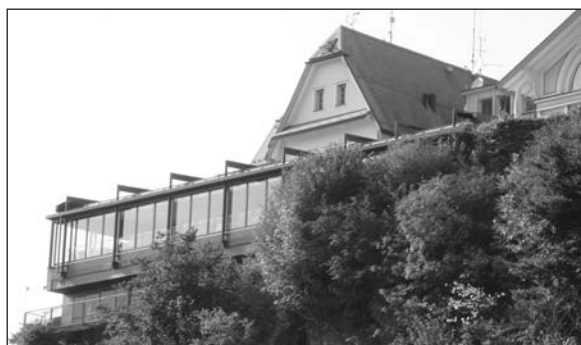
Ohne Bewilligung erstellt: Überbauung Südterrasse.
