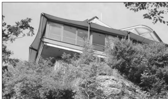
Ohne Bewilligung erstellt: Überbauung Westterrasse.
