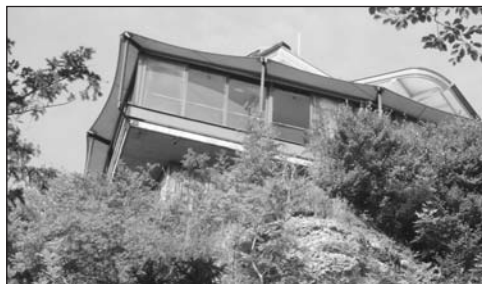
Ohne Bewilligung überbaut: Die West-Terrasse – für Wanderer nicht mehr zugänglich.
