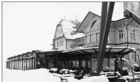
Illegal in Stahl und Glas eingepackt: Die Süd-Terrasse ist heute der Event-Saal.
