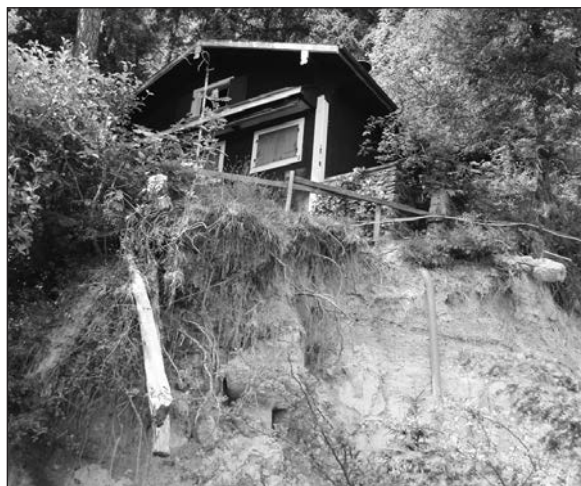
Wie ein Adlerhorst: Die Bristenstöffeli-Hütte an exponierter Stelle. Ein Teil des Gärtchens samt Mauer ist schon abgestürzt. Der Hang muss verfestigt werden.
