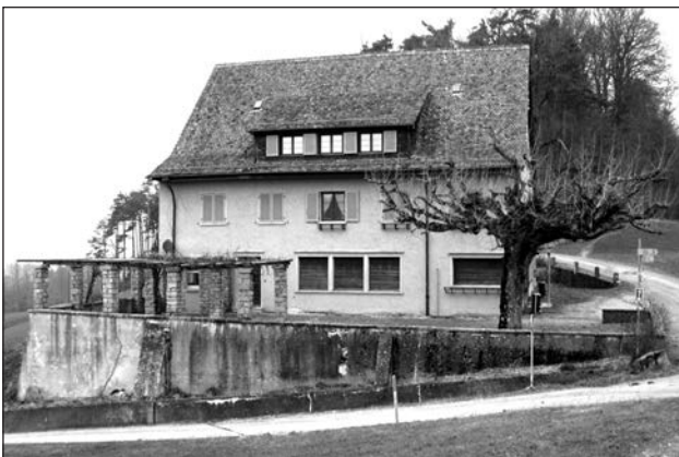
Baldern verlottert: Farbe blättert ab, Putz fällt von der Fassade, Sprünge in den Stützmauern, Garten verwildert.
